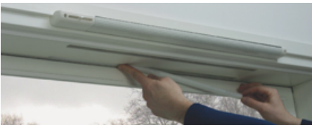
VÄLITILAN SUODATTIMEN IRROITUS / ASENNUS
