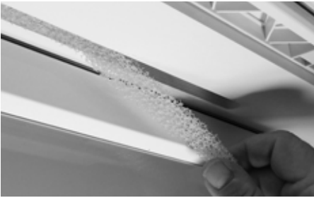
VÄLITILAN SUODATTIMEN IRROITUS / ASENNUS
