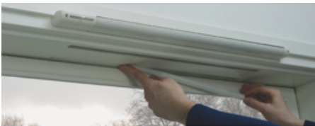
VÄLITILAN SUODATTIMEN IRROITUS / ASENNUS
